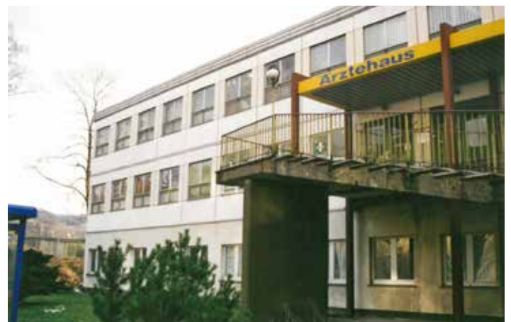
Im Februar 1995 starteten die dringend notwendigen Sanierungsarbeiten am Ärztehaus.
